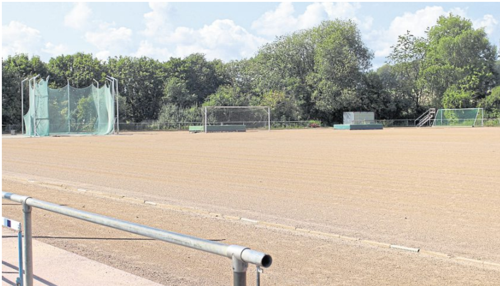
Die Sportanlage in Holzappel hat eine Sanierung nötig. Darüber wurde jetzt in einer gemeinsamen Sitzung des Bau- und Planungsausschusses und des Sportausschusses der Verbandsgemeinde Diez beraten.
